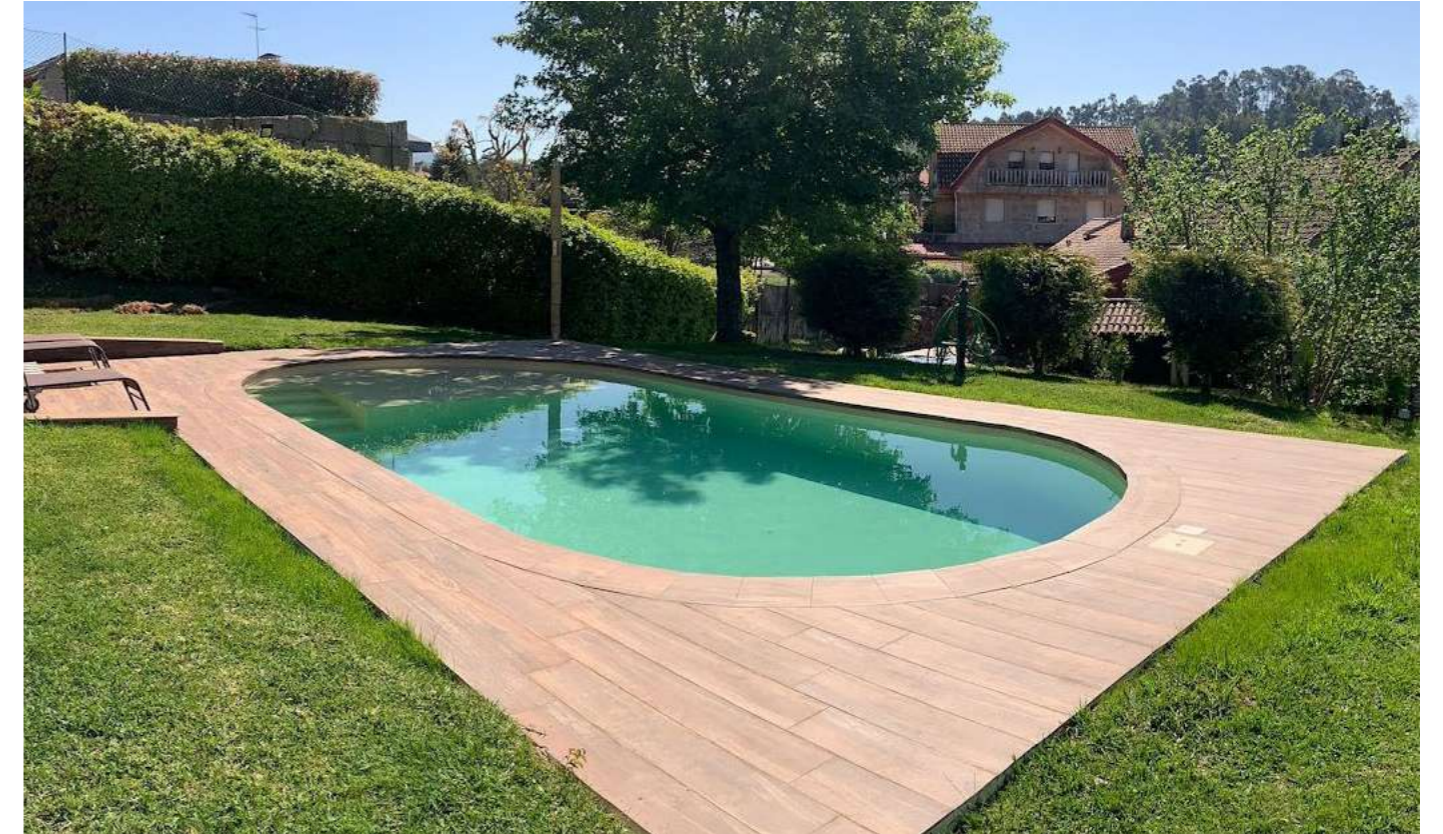
Piscina Serie Madera, modelo Taiga coronada con peldaños rectos cortados en pequeñas secciones para crear una curva perfecta. Swimming pool Serie Madera, model Taiga crowned with straight steps tiles cut in small sections to create a perfect curve.
